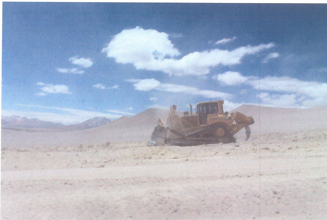
Buldozer trabajando, sin humectación modificando el trazado del camino principal.
