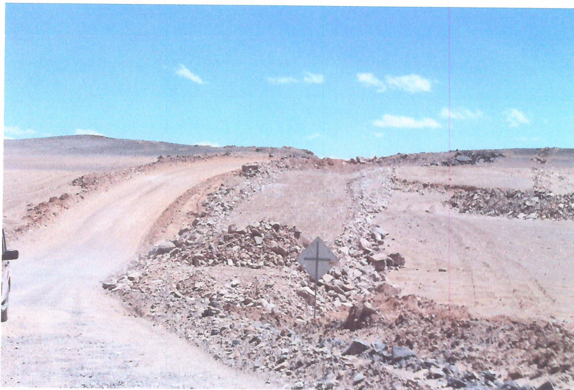
Relleno de nuevo camino con material grueso.
