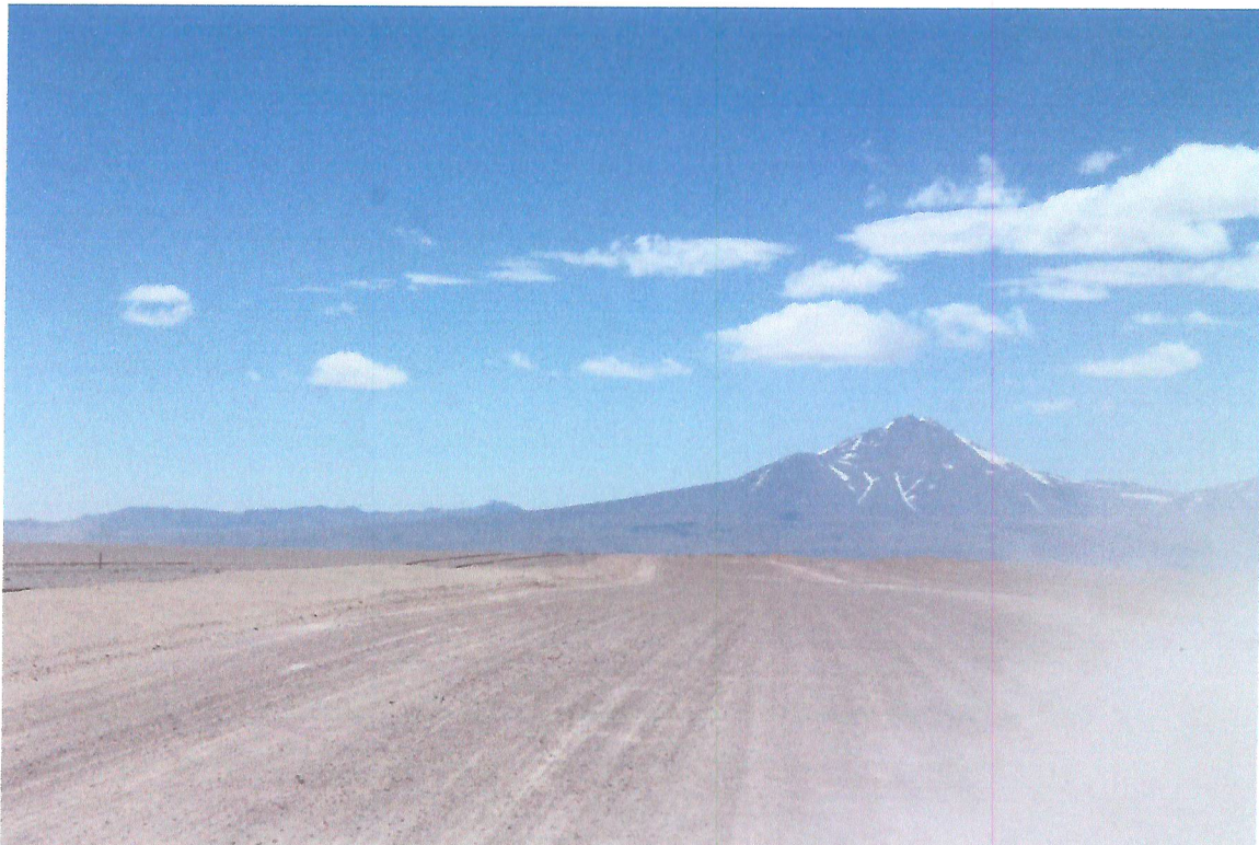
Camino excesivamente ancho y no hidratado.
